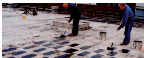
1. Penetrácia podkladu náterom FG35.
